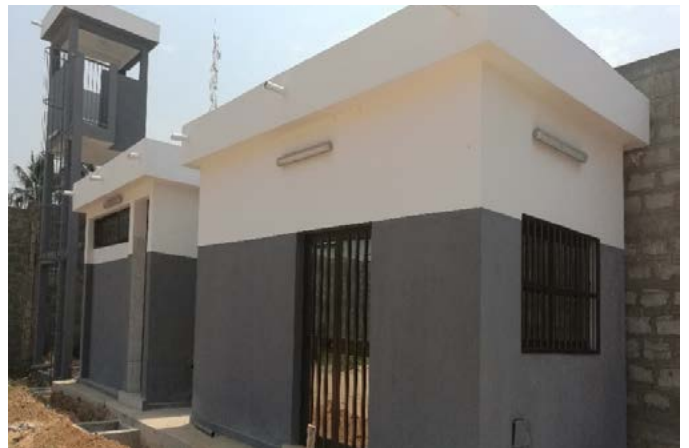
Travaux compensatoires à la base marine
