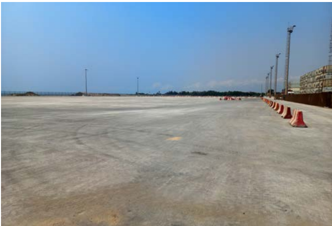
Travaux d'extension du côté Sud-Est du parc
